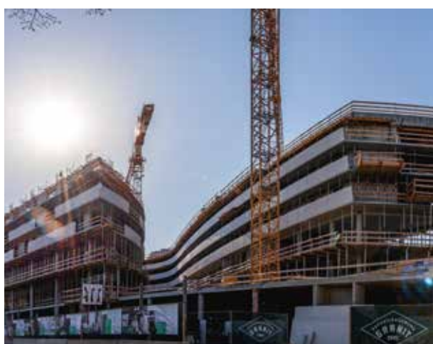
Wohn- und Bürohaus Messecarree, Wien
