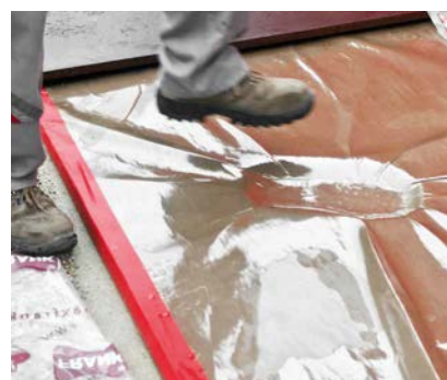
después de 24 horas se ha derrumbado la capacidad de carga de la placa de asiento Egcovoid®
