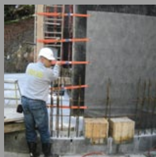
Contentore per acqua a Trin (CH), 2008
