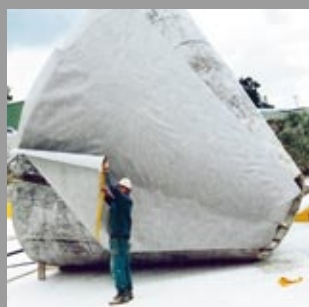
Depuratore a Monaco, 1990
