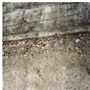
Degrado da acqua di scarico
