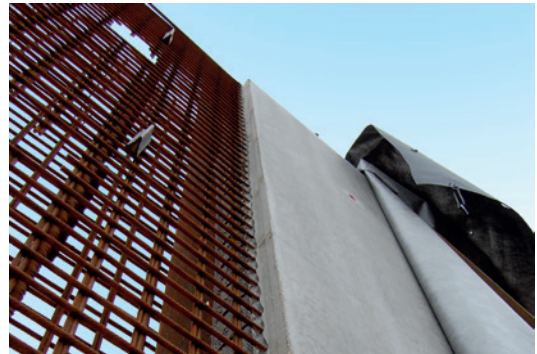
Techniques de coffrage
