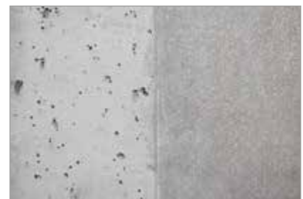
Sans Zemdrain® (gauche) vs. avec Zemdrain® (droite)
