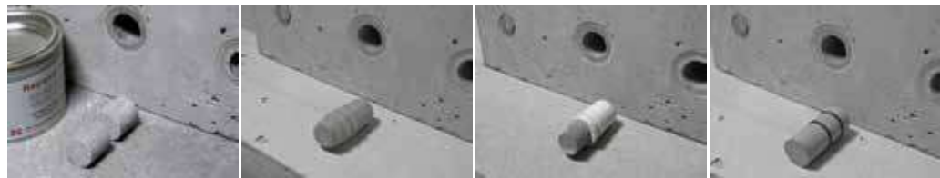
Tapón de hormigón reforzado con fibras
