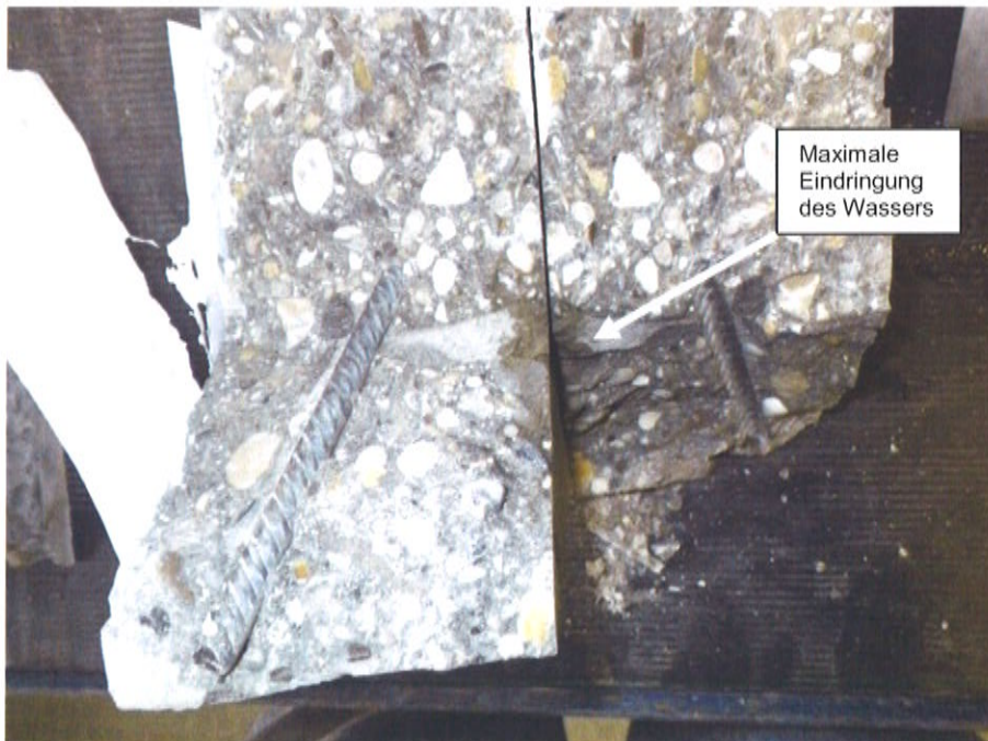
Bild 4: Probe 2 nach dem Aufspalten zur Messung der Wassereindringtiefe 10 mm
