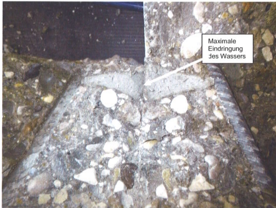
Bild 5: Probe 3 nach dem Aufspalten zur Messung der Wassereindringtiefe 3 mm
