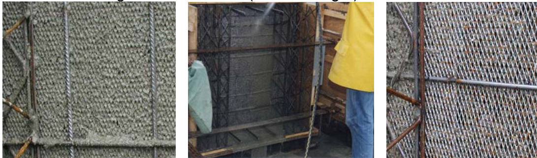
Abbildung 9: Betonoberfläche ohne (links), während (Mitte) und nach (rechts) dem Abwaschen
