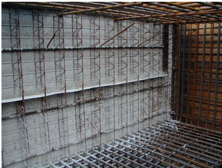
Abbildung 6: Mit Stremaform geschaltete hohe Fuge (ca. 2000 mm)
